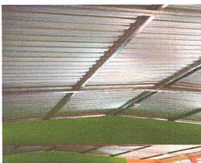
Foto1: FINALIZACION DE LA ESTRUCTURA DE TECHO DEL MODULO No. 1
