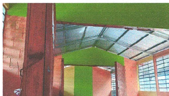
Foto 4: APLICACIÓN DE PINTURA EN MURO INTERIOR DEL CENTRO EDUCATIVO.
