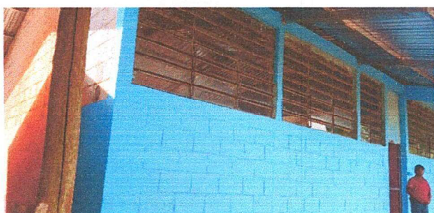
Foto 3: APLICACIÓN DE PINTURA EN MURO EXTERIOR DEL CENTRO EDUCATIVO
