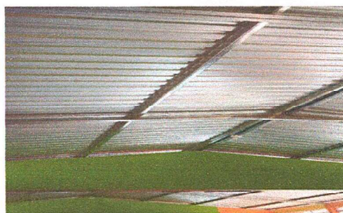
Foto 2: FINALIZACION DE LA SUSTITUCION DE CUBIERTA DE LAMINA DEL MODULO No.1
